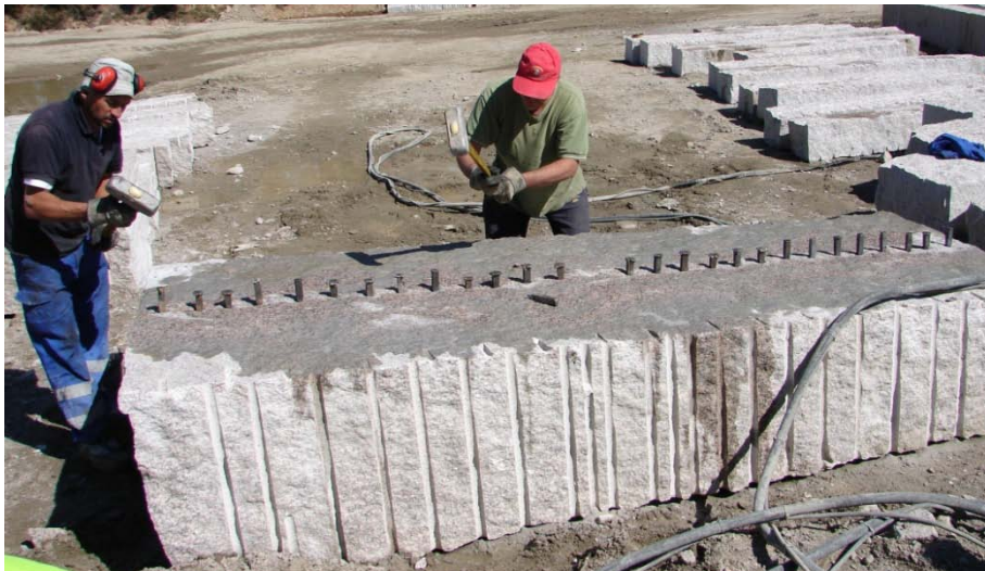
Figura 2.8. Introduciendo cuñas manualmente para abrir perpiaño
