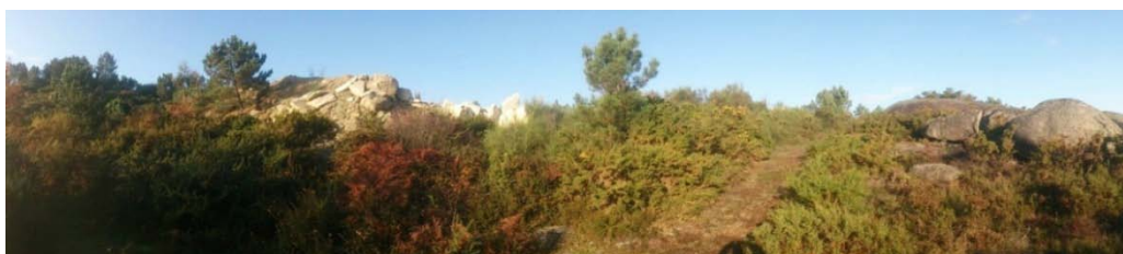
Figura 4.4. Ejemplo de apantallamiento en escombreras de explotaciones de granito
